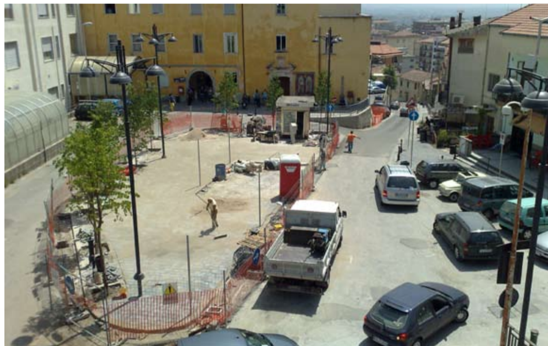
EBOLI, LAVORI DI RIFACIMENTO DI PIAZZA SCUOLA MEDICA SALERNITANA
