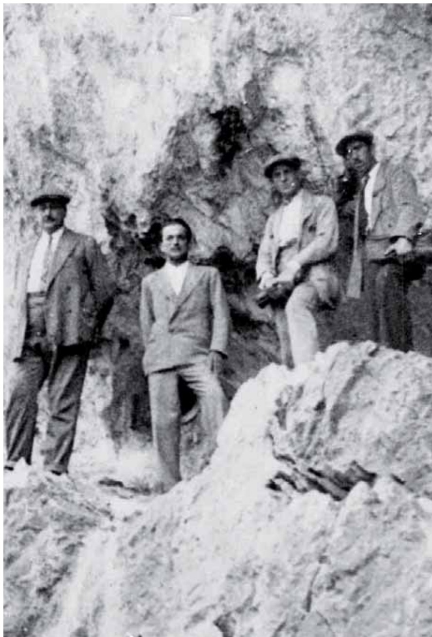
Lavori di costruzione dell'acquedotto dell'Acero, a sinistra Antonio Storniello
